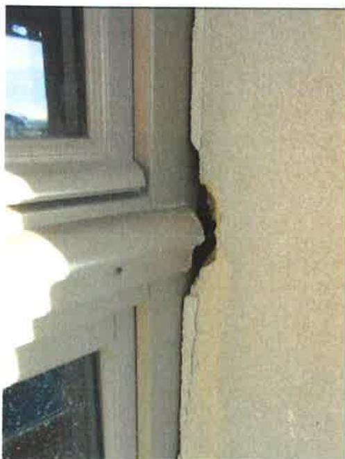
05.12 : Encadrement éclaté après pose de la menuiserie, à réparer par Déco Façade pour Couval
