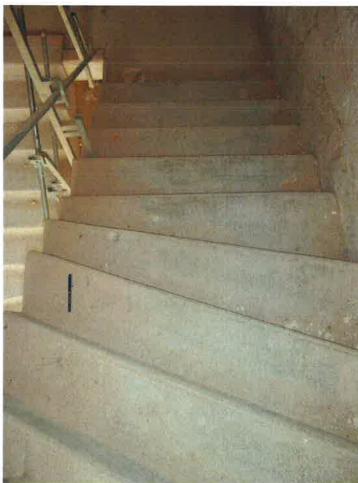
19.06 – tous escaliers balancés : balancement 20 ème marche à reprendre, et parallélisme 23 ème marche à reprendre.
