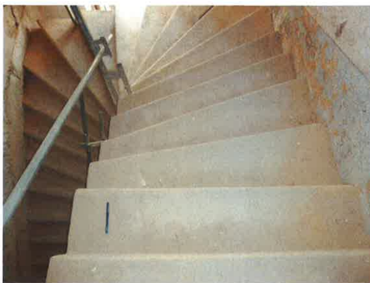
19.06 – tous escaliers balancés : parallélisme 5 ème marche à reprendre, et balancement 7 ème marche à reprendre
