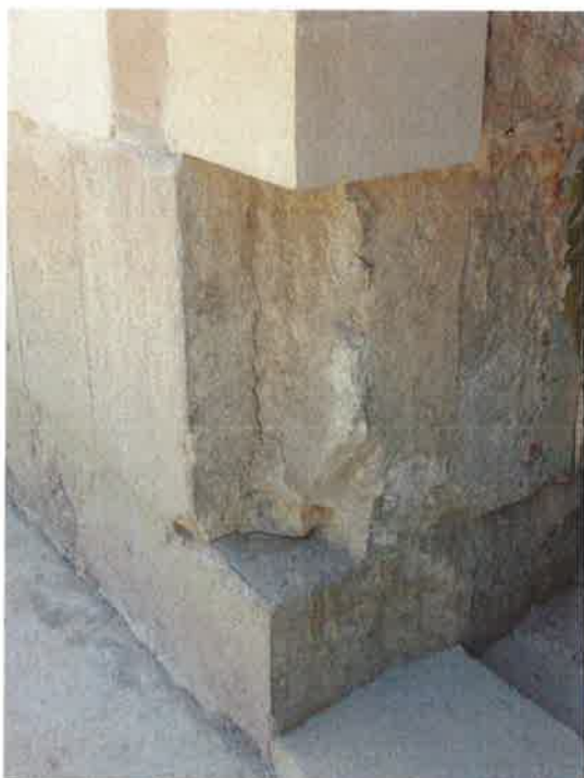
03.07 : travaux au RDC à terminer au RDC / ROC FACADE
