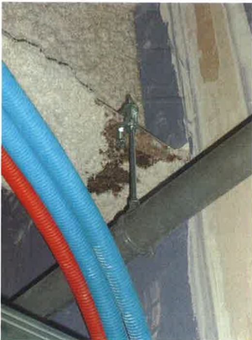
26.06 : sondage au R+1, pas de flocage sur la poutre, à compléter / H.T.
