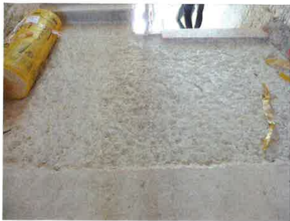
03.07 : piochage palier R+2 en cours / BEC
