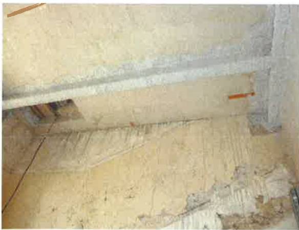
26.06 : réservations derrière ascenseur à achever par BEC
