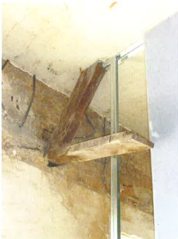
19.06 : pièce d'appui à couper, trou à boucher
