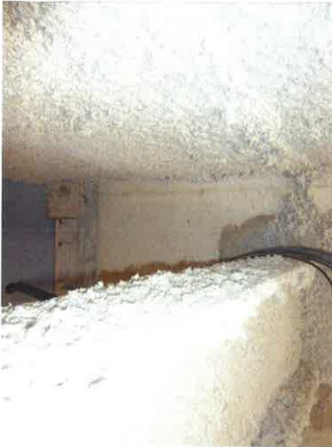
26.06 : sondage au R+1, pas de flocage sur la poutre,
