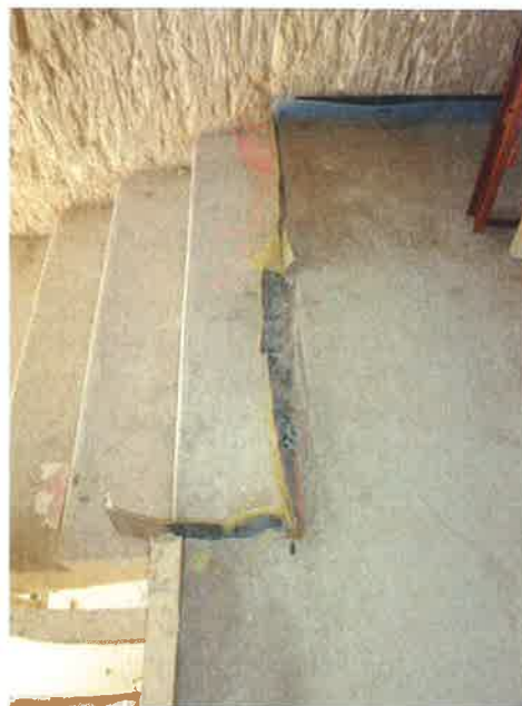
26.06 : réservations R+1 2.5 cm pour 6 cm, chape en surépaisseur, support à piocher par BEC
