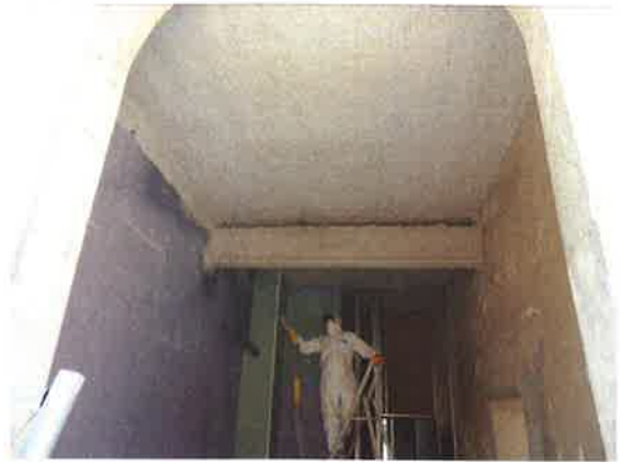
03.07 : flocage dessus poutre en cours / BEC
