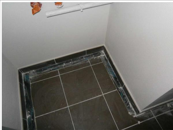
La pose des plinthes carrelage a été réalisée conformément aux précautions de mises en œuvre du CCTP Acoustique.
