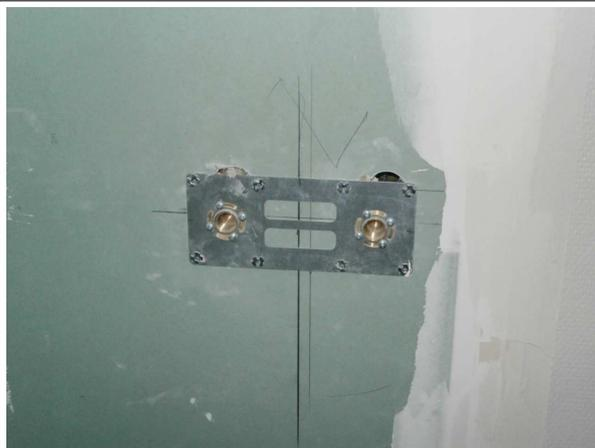
Le rebouchage des réservations des tubes PER des douches à l'italienne n'est pas réalisé.
