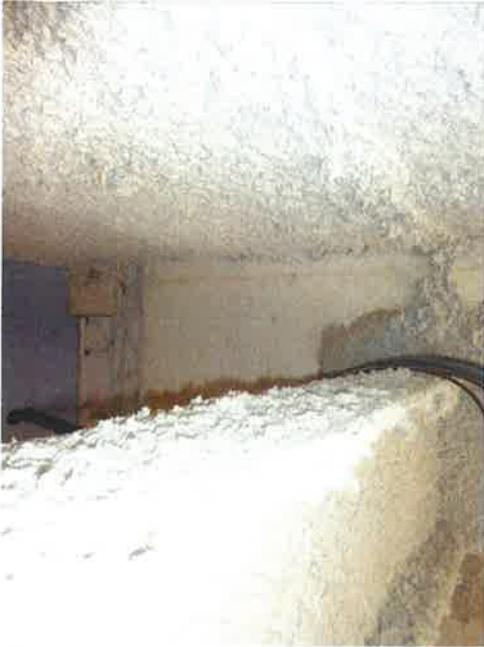
26.06 : sondage au R+1, pas de flocage sur la poutre, à compléter par BEC selon PV
