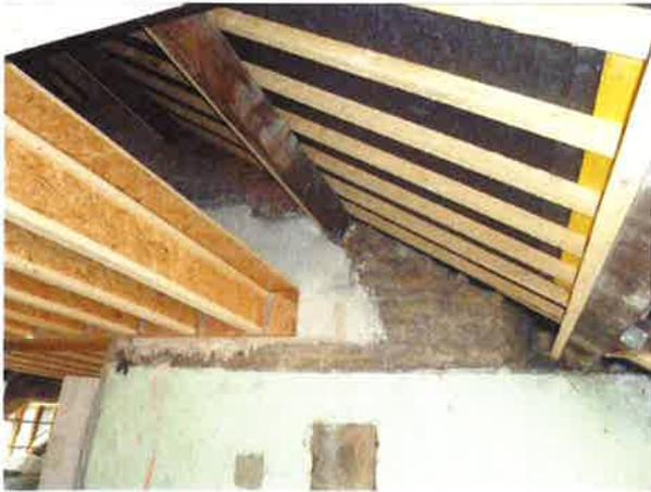
05.05 : liaison plancher / rampant non conforme au DCE, à modifier par C2C
