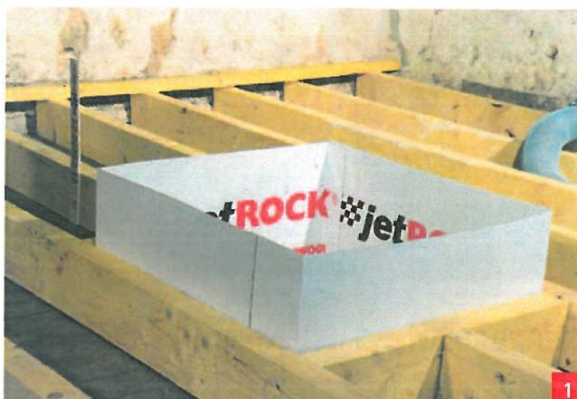
**NOTA BENE :** la trappe d'accès doit être isolée à l'aide d'un panneau de laine de roche offrant une résistance thermique au moins égale à celle de la laine soufflée, si elle est située au dessus d'un local chauffé.
