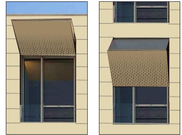
Principe d'ouverture et fermeture du store-auvent
