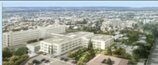
Centre hospitalier d'Aix en Provence Architecte : Groupe-6 Entreprise : GCC
