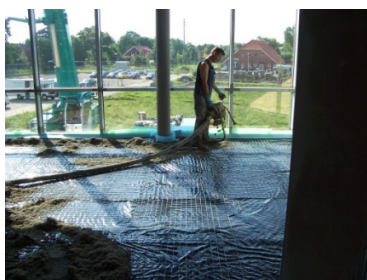
Montage de la chape
