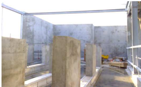
Figure 24 : Longrines à 1m80 de hauteur pour accueillir l'ossature métallique support des groupes froids
