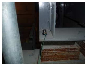
Figure 14 : Supportage de la machinerie sur patin acoustique
