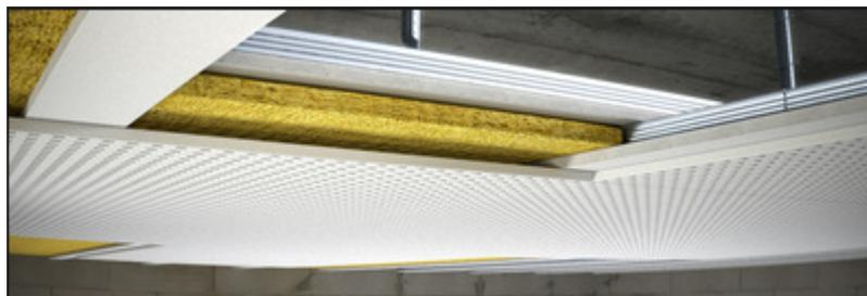
Figure 6 : Exemple de solution acoustique en plaques de plâtre perforé
