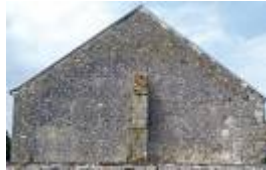
mur pignon d'une grange
