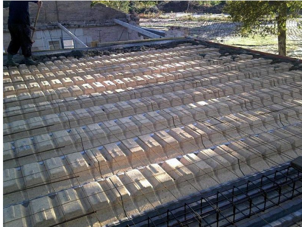
Plancher Hourdis vu de dessus
