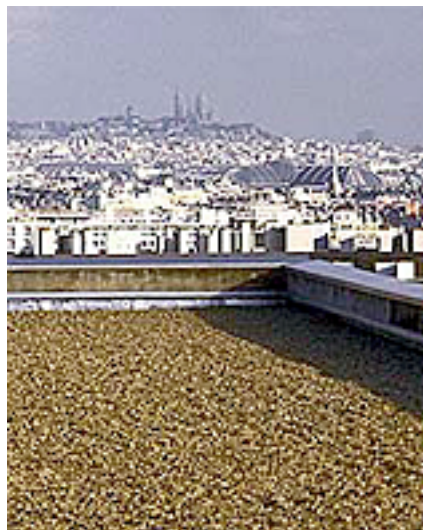
Gravillons sur toiture terrasse.
