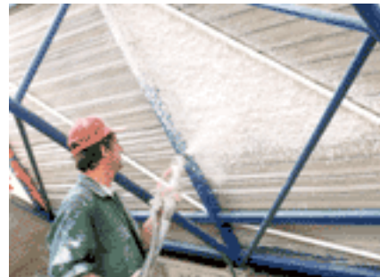
Flocage de laine de roche.
