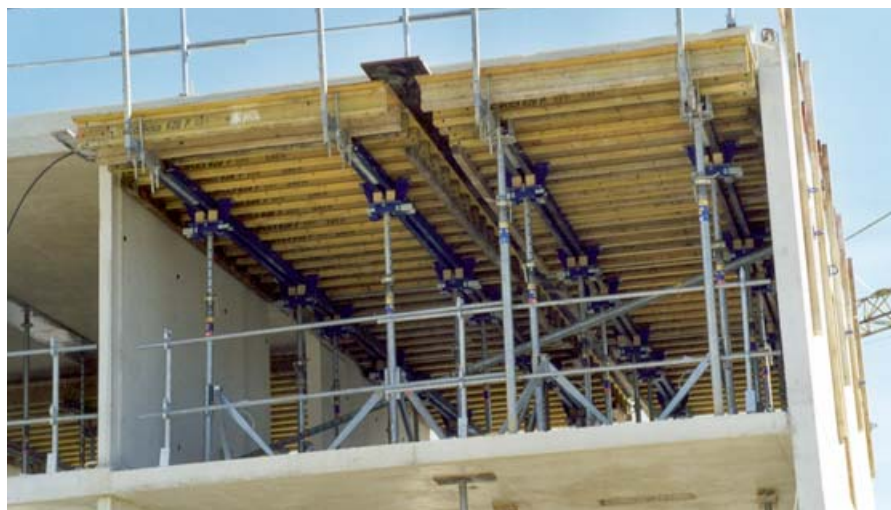
Coffrage de dalle en béton au moyen de systèmes modulaires.
