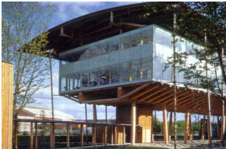
Ossature bois : bâtiment du CTBA de Bordeaux, architectes Philippe Pascal et Alain Loisier
