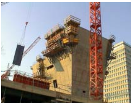
Structure en béton.
