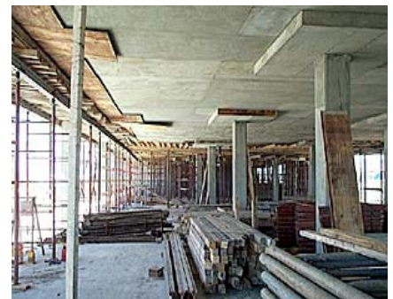
Structure poteaux, dalle en béton.
