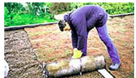
Ci-dessous, pose d'une toiture végétalisée à Paris dans le XVIII ème arrondissement.
