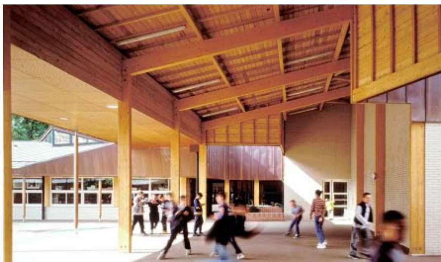
Ci-dessous, ossature bois en lamellé-collé.
