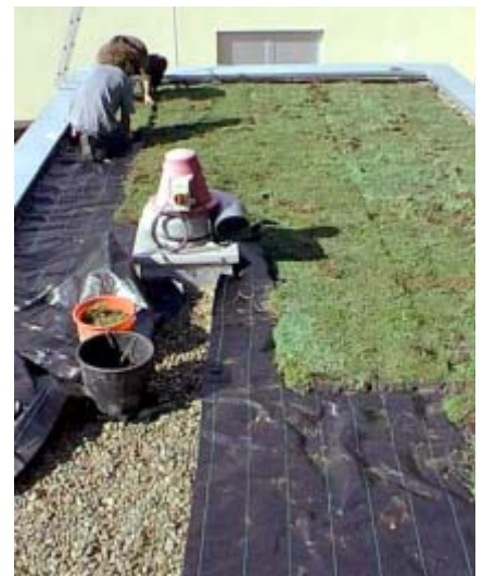
Mise en œuvre d'une toiture végétalisée.
