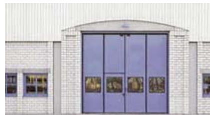
Mur en briques silico-calcaires.
