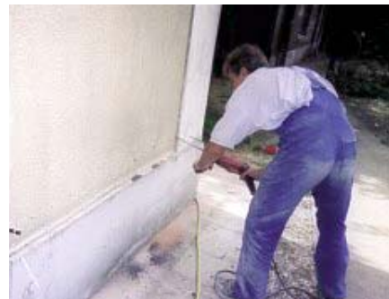
Traitement de l'humidité.
