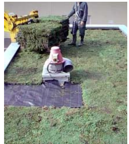
Ci-dessus, pose de panneaux de sédum. Ci-contre à gauche, détail.
