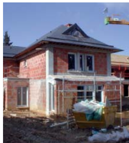
Murs en briques creuses.
