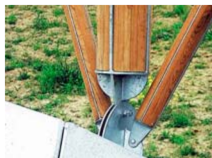
Assemblage métallique pour structure bois.
