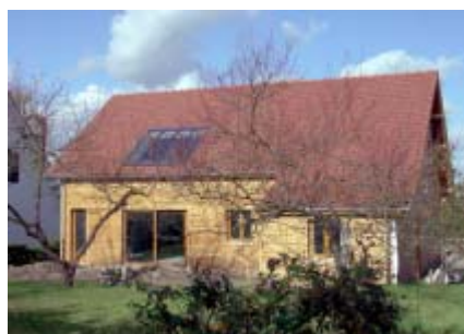
Toiture à double pente.
