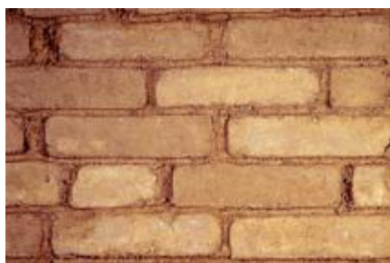
Mur de briques en terre crue.
