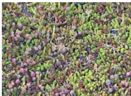
Sedum utilisé en toiture.
