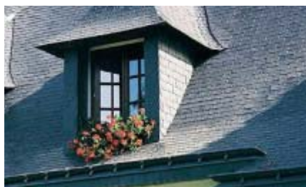
Toiture en ardoises.
