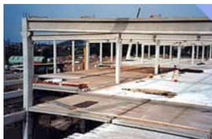
Construction en béton préfabriqué.
