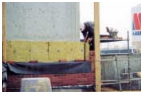
Mise en œuvre d'une isolation par l'extérieur (lycée de Caudry - 59).
