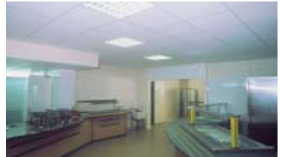
Dalles de faux plafond acoustique.
