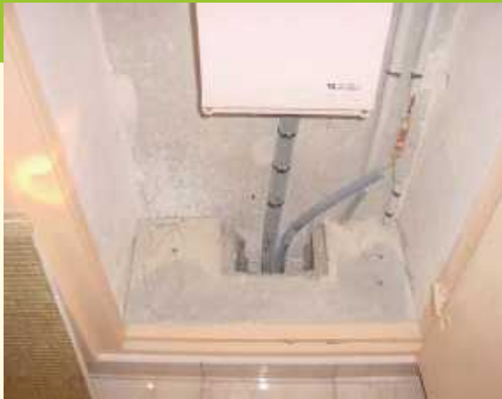
Recoupement des gaines techniques
