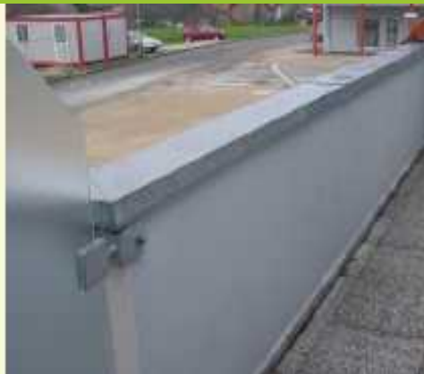
Garde-Corps Balcon < à 1m de hauteur
