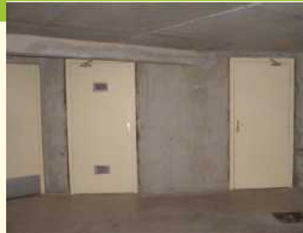
Communication des locaux communs ou sas avec le parc (Degré coupe-feu non respecté)
