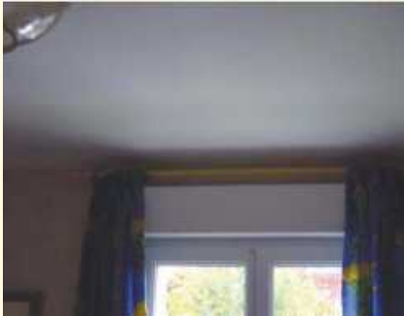
Absence d'entrée d'air dans pièce principale
