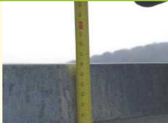
Garde-Corps Balcon < à 1m de hauteur
