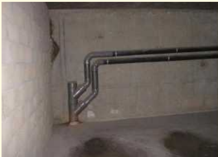
Protection des conduits et gaines
