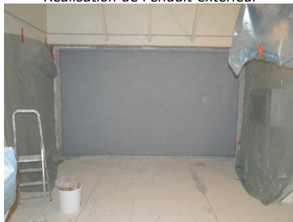
Mise en œuvre du revêtement d'étanchéité intérieur
