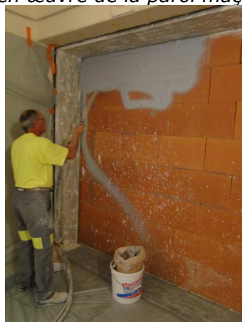
Mise en œuvre du revêtement d'étanchéité intérieur
