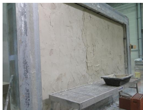
Réalisation de l'enduit extérieur
