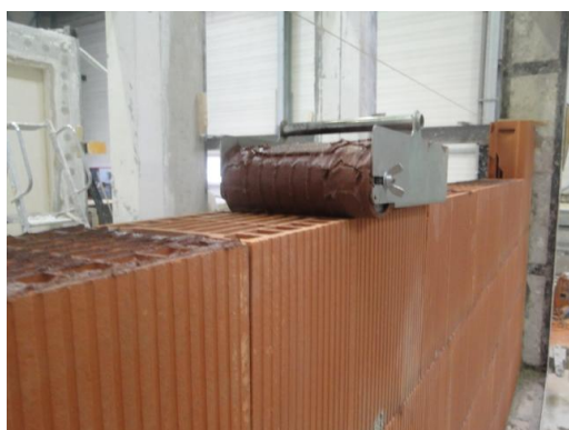
Mise en œuvre de la paroi maçonnée
