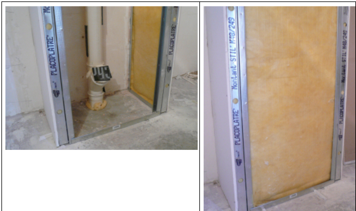
Gaine N= 1 : Contre cloison Placostil® 72/48 – BA13 std
