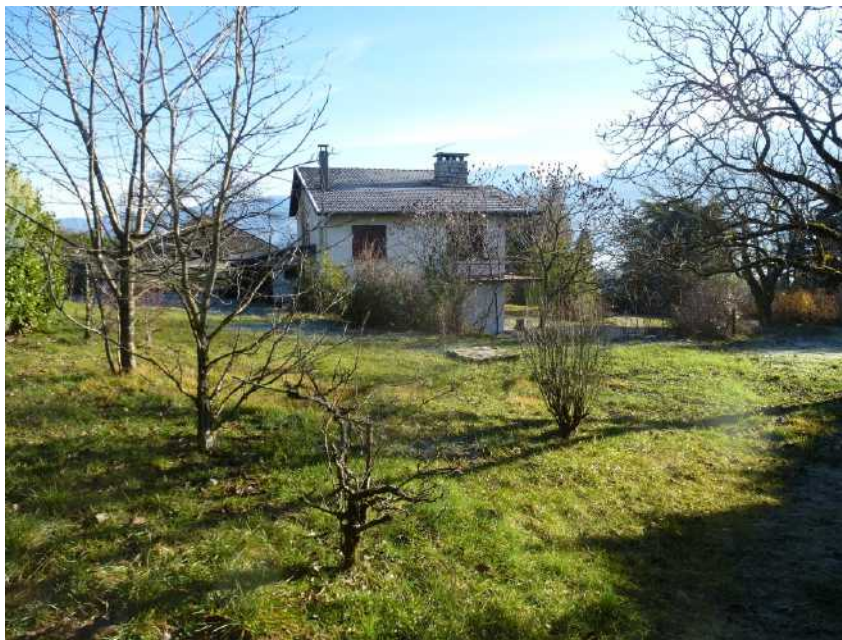
Photo n° 4 : Vue d'ensemble depuis l'angle Sud de la propriété
